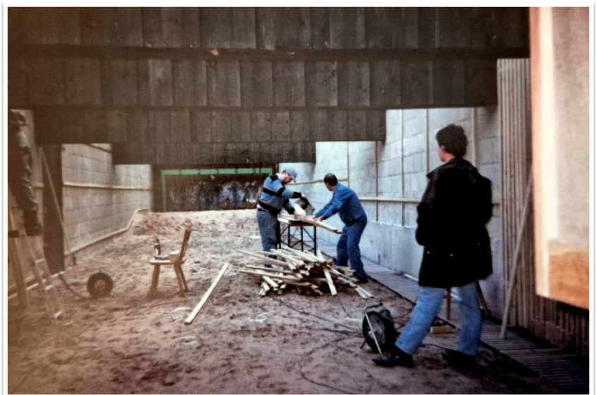
Arbeiten zur Erweiterung der Pistolenbahn mit Schallschutzwänden (1989)
