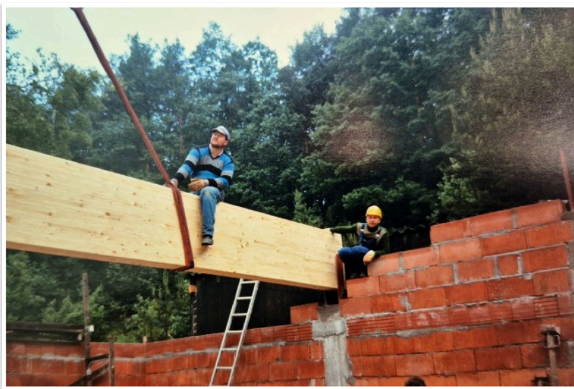
Die Dachträger der neuen Drucklufthalle werden eingelassen (1989)
