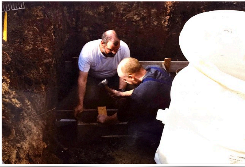
Vereinsmitglieder bei Kanalarbeiten zum Anschluss des Schützenhauses an das öffentliche Abwassersystem (2006)
