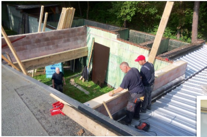
Sanierungsmaßnahmen Dach und Schießbahnen (2013)
