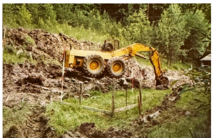
Schweres Gerät beim Bau der Kurzaffenbahn (1983)
